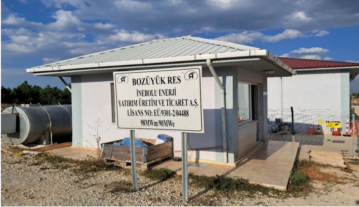
Fotoğraf 1. Bozüyük RES Yönetim binası girişi
